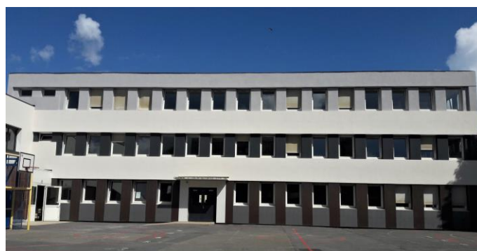
Isolation du bâtiment C
